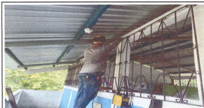
Foto 3: SUSTITUCIÓN DE BALCONES DE METAL.
