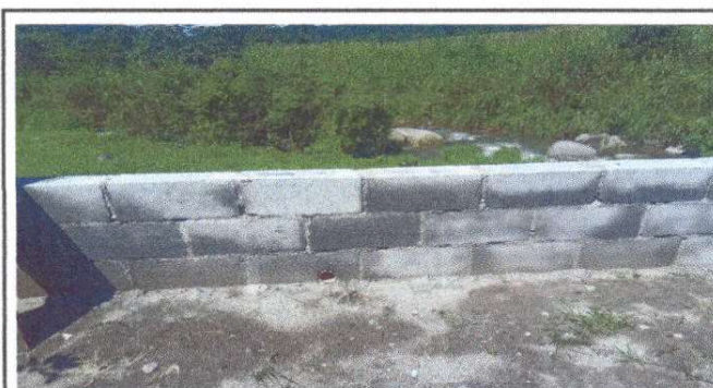
Foto 6: REPARACIÓN DE MURO PERIMETRAL DE BLOCK.
