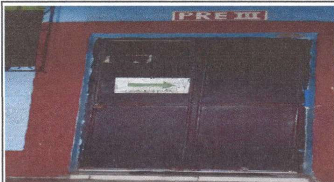
Foto 1: MANTENIMIENTO DE ESTRUCTURA (PUERTA) Y CAMBIO DE CHAPA.
